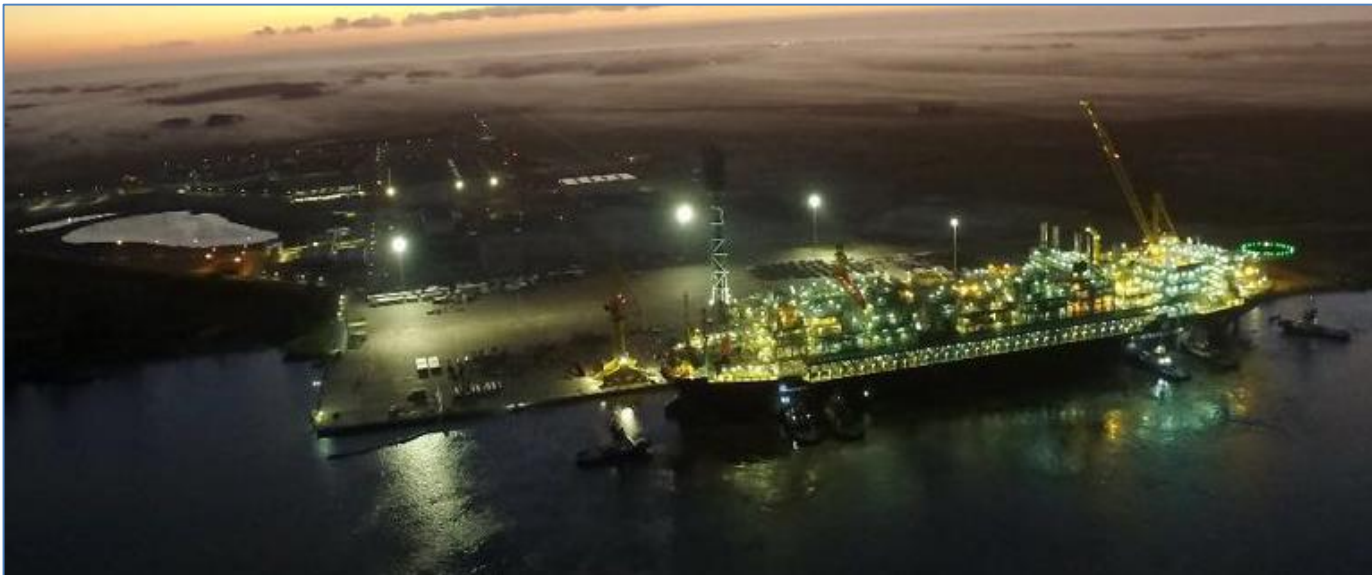
Foto: FPSO P-74/Petrobras
