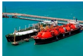
Terminal de GNL
