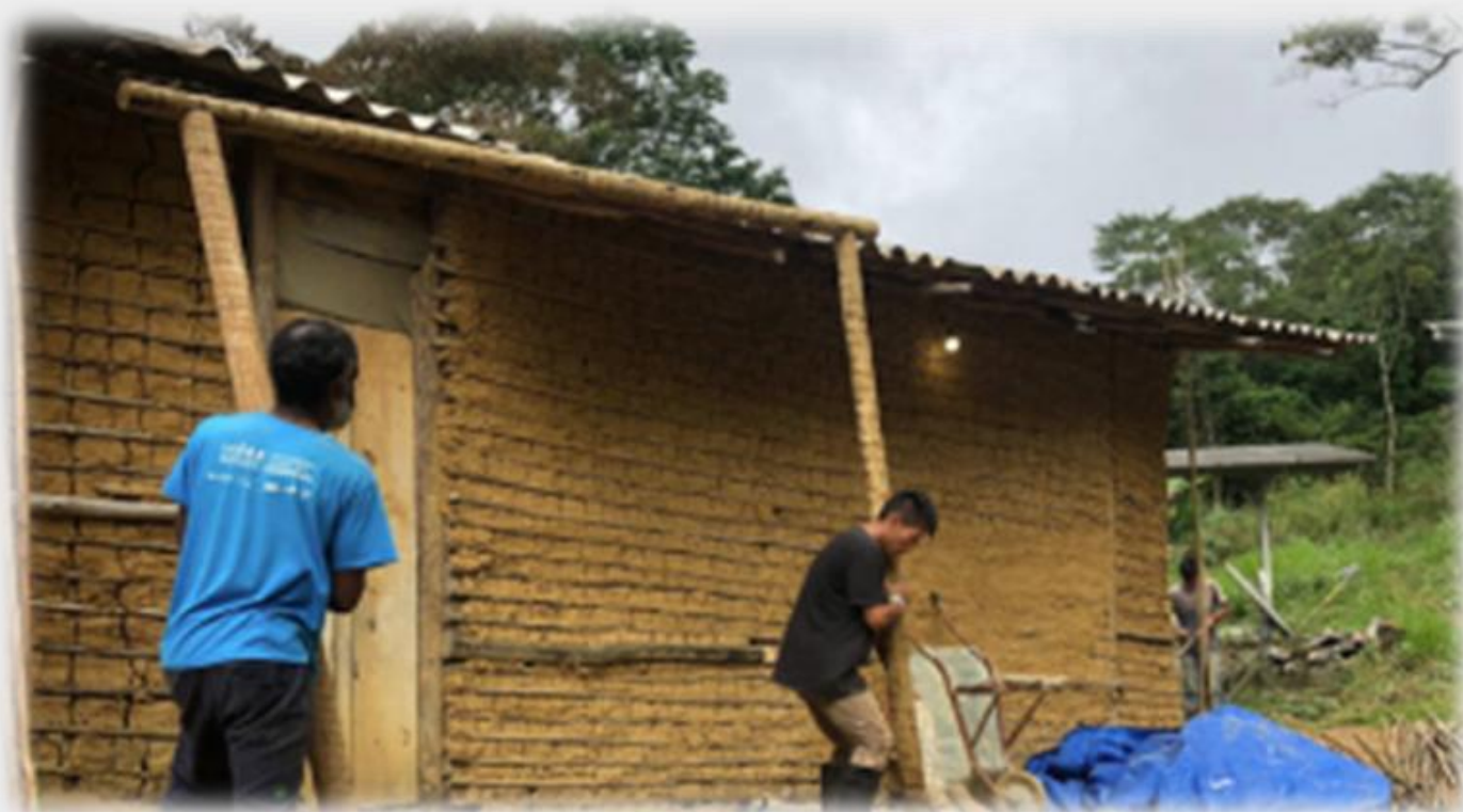
Construção dos banheiros na aldeia Araponga
