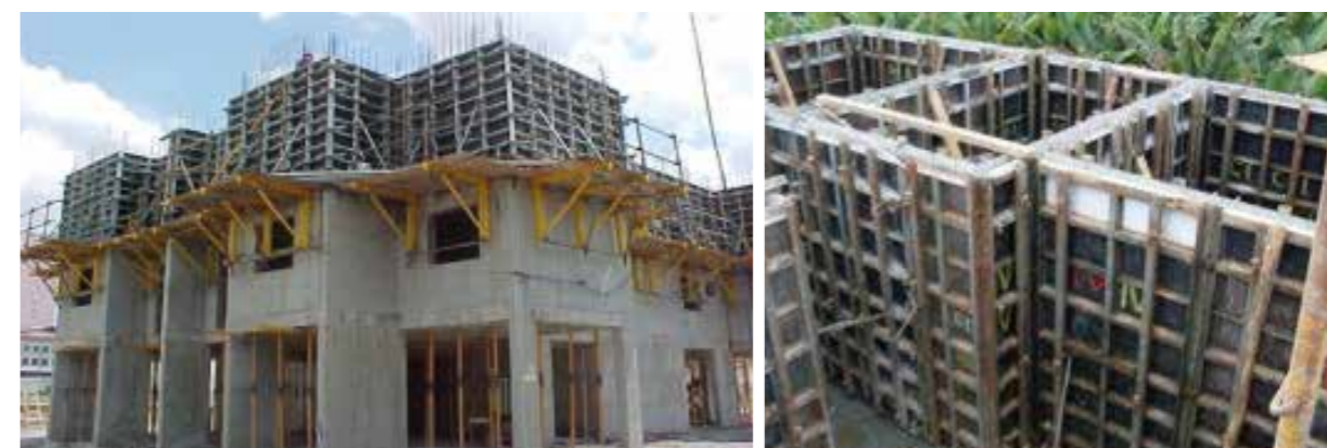
Figura 29 | Sistema construtivo de paredes maciças de concreto com uso de fôrmas mistas
