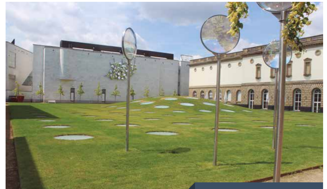
Figura 8 | Projeto de ampliação do Museu Städel em Frankfurt: uso do espaço subterrâneo abaixo do jardim, utilizando luz natural por meio de claraboias circulares de vidro isolante e sistema de sombreamento, como proposta de eficiência energética.
