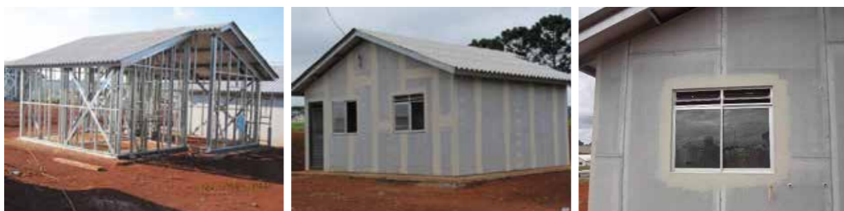
Figura 36 | Sistema Light Steel Framing para a produção de habitação para uso em casas térreas
