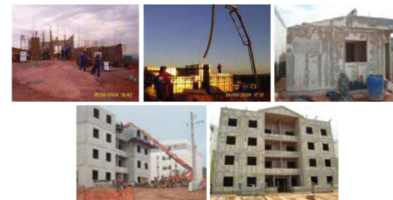
Figura 30 | Sequência de execução de casas com paredes maciças moldadas no local com fôrmas metálicas e resultado após a desforma: necessidade de desenvolvimento de concretos com características reológicas adequadas às condições de lançamento e espessura das paredes
