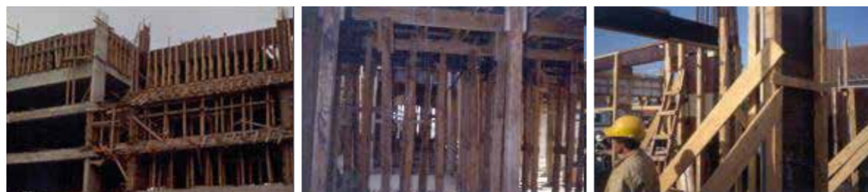
Figura 23 | Exemplos de tecnologia tradicional. Sistemas de fôrmas comumente utilizados em processos tradicionais de produção de ERCA
