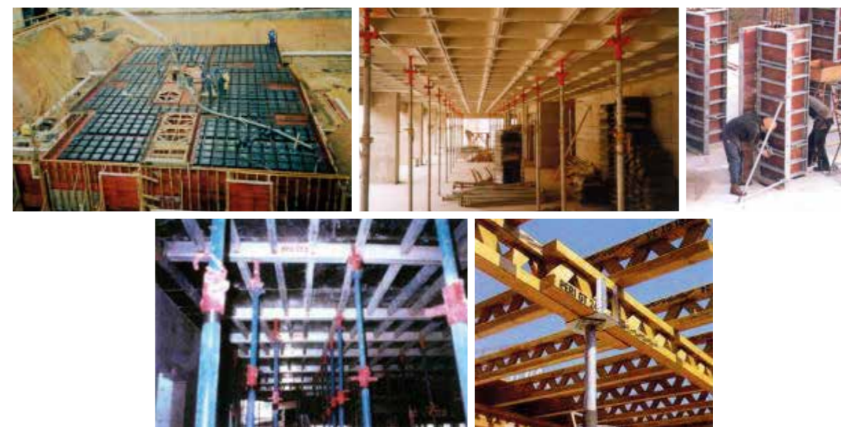
Figura 24 | Exemplos de processo produtivo altamente racionalizado. Sistemas de fôrmas racionalizadas disponíveis no mercado nacional para produção de ERCA
