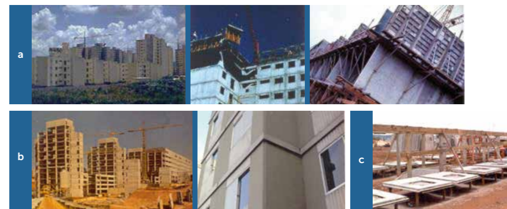
Figura 18 | Introdução de sistemas industrializados. Conjuntos habitacionais de meados da década de 1980 em São Paulo: (a) Sistema de paredes maciças de concreto moldadas com fôrmas de aço – sistema Outnord; (b) edifício com painéis e lajes pré-fabricadas de concreto; (c) produção de painéis pré-fabricados de concreto em usina, para edifícios de múltiplos pavimentos
