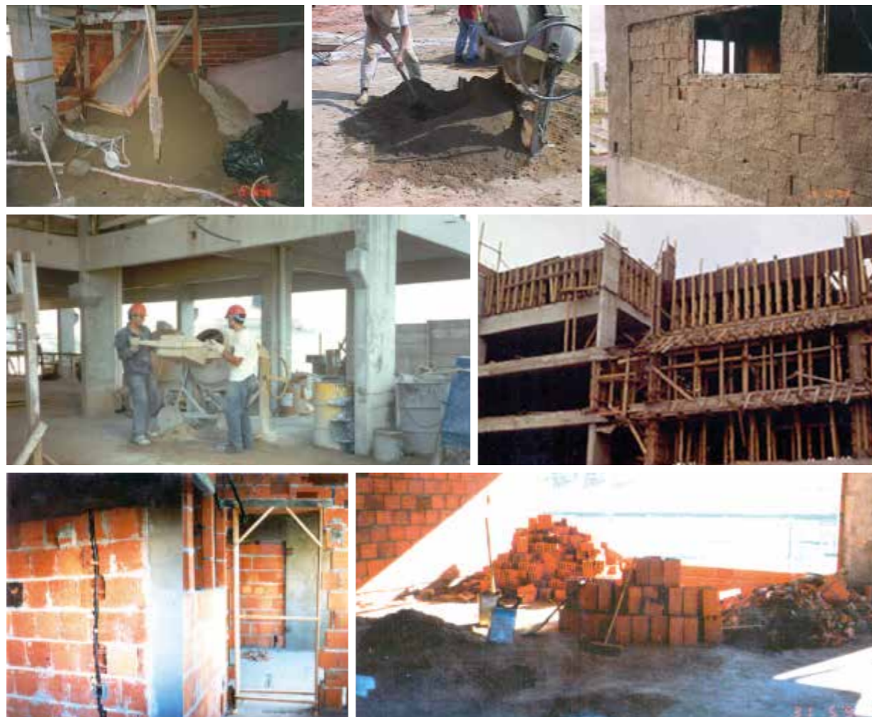
Figura 20 | Condições de produção ao longo do período pós-extinção do BNH (início da década de 1990) até fins do século XX: baixa produtividade, desperdícios de materiais, subjetividade nas decisões de produção, larga interferência entre os subsistemas
